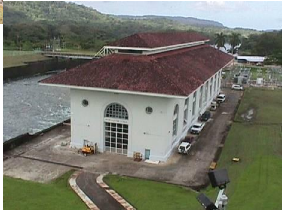
Planta Hidroeléctrica Gatún 24 MW
